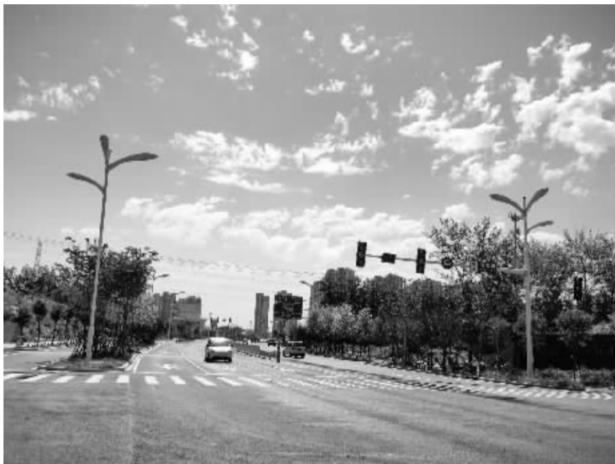
■塔北路(东二环—复兴大街西侧辅路)工程通车后,周边居民出行更畅通。
