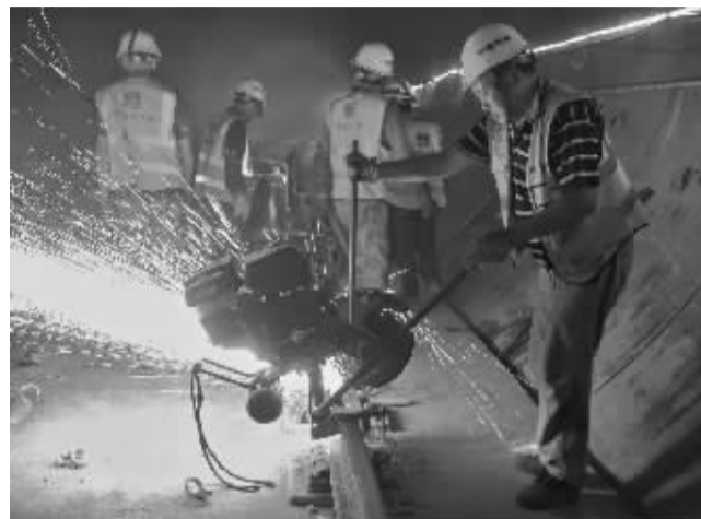
建设现场,建设者正在紧张施工。
