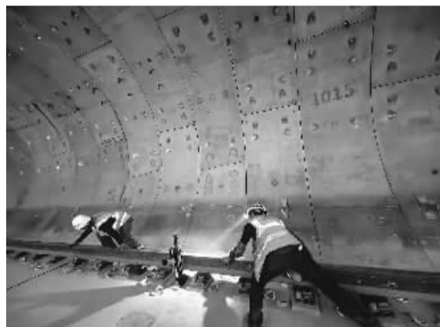
建设者在努力调整钢轨位置。
