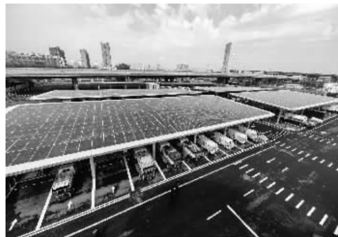
■车棚为光伏车棚,下方大型车辆正在充电。本报记者 冯月静 摄
