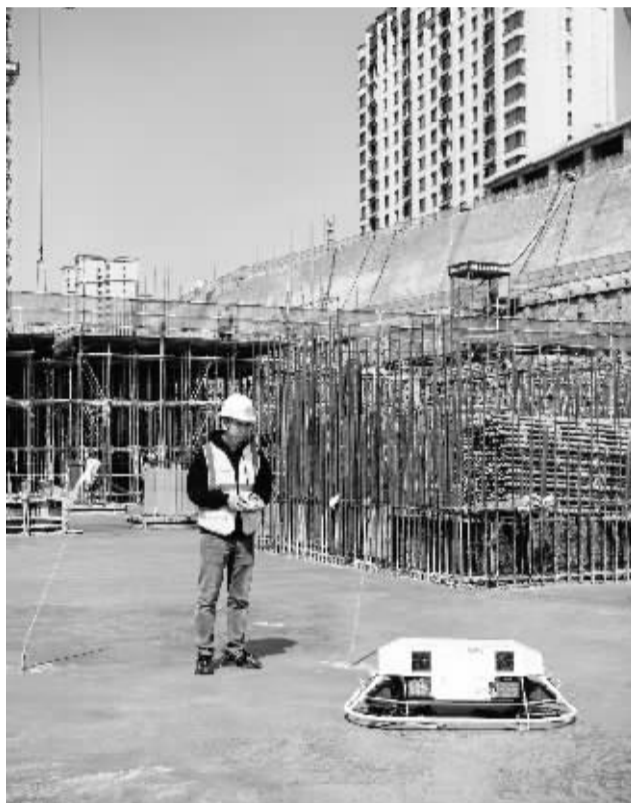
■一名建设者操控遥控器,远程遥控磨光机开始自动工作。
