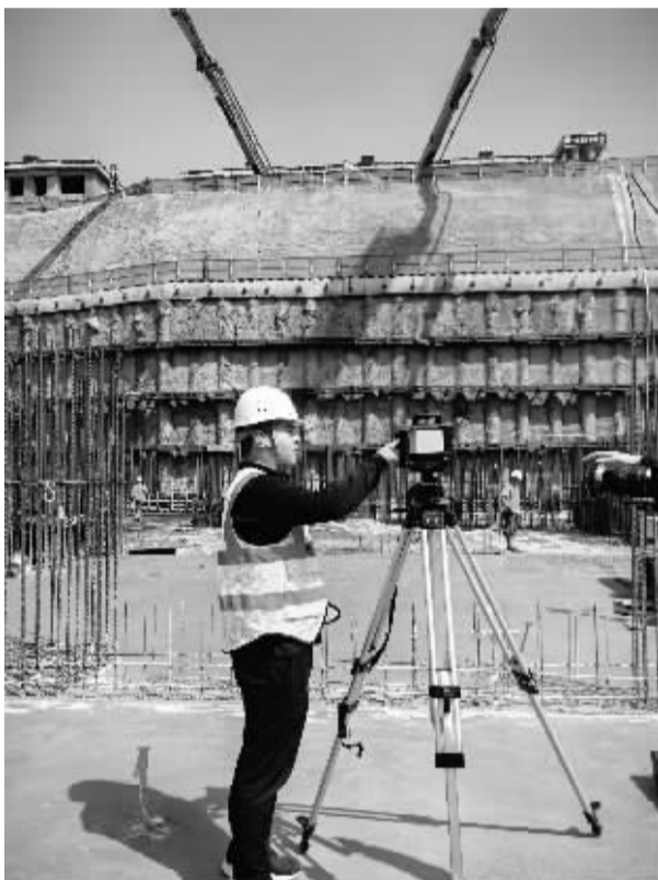
■一名建设者正在操控激光发射器。
