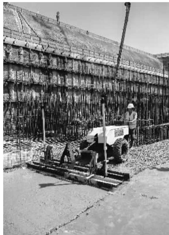
■一名建设者正在操控激光整平机作业。
