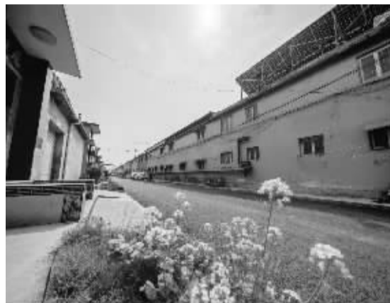
■国道G307—井陘上安东贾家沟路段已通车。
