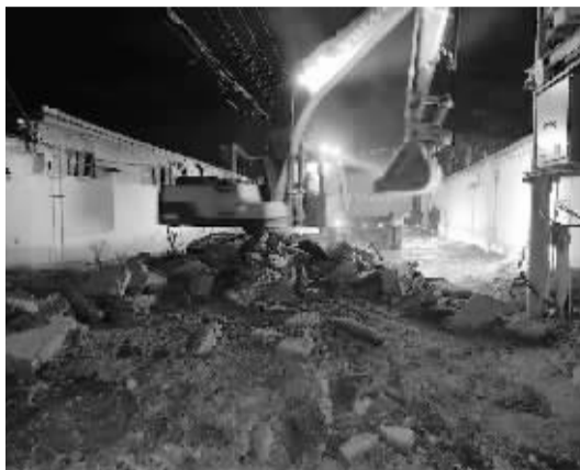
■赵县赵辛线—潘村路段正破除旧路面。(石市交通运输局供图)
