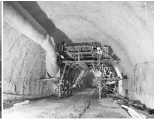
■衡昔高速太行山特长隧道二衬施工。
