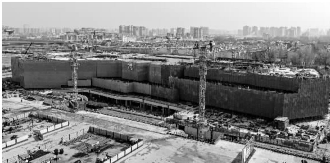
留营片区特色商贸区2号地块主体结构封顶。石家庄日报客户端记者 张润东 摄
