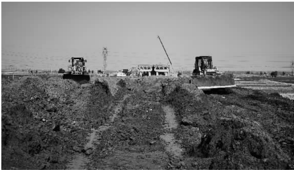
■国道 G515 无极县绕城段改建工程路基施工。通讯员 王建勋 摄
