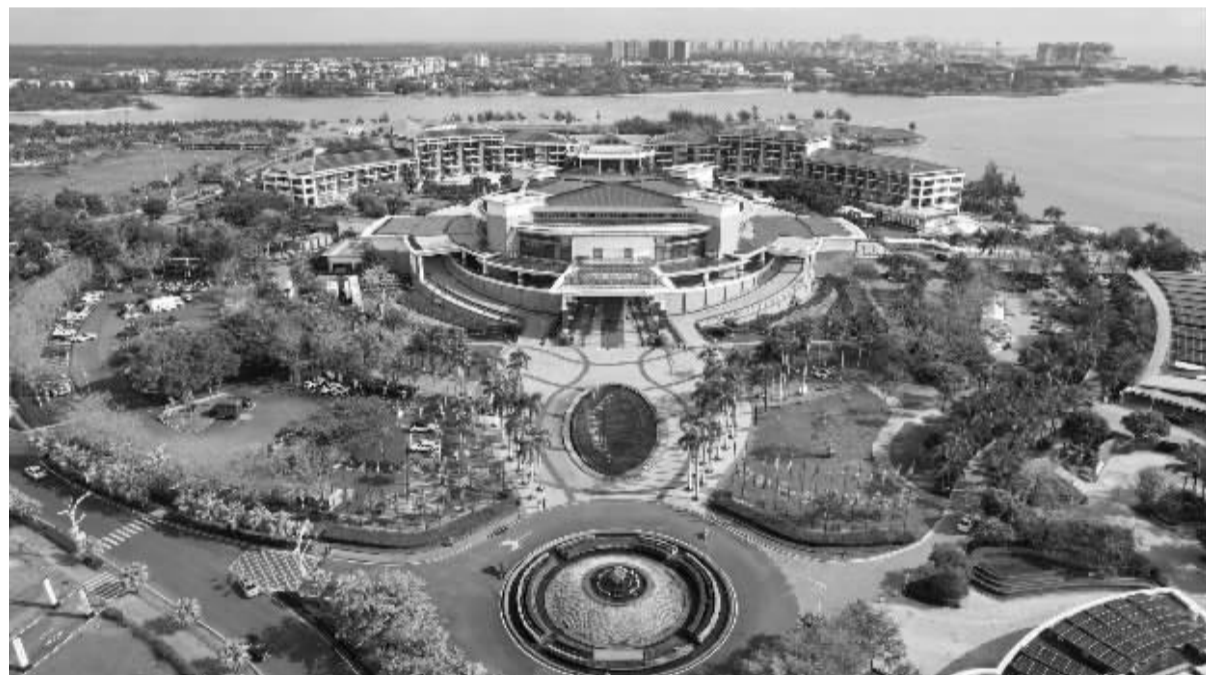
■3月20日拍摄的博鳌亚洲论坛国际会议中心。新华社记者 杨冠宇 摄
