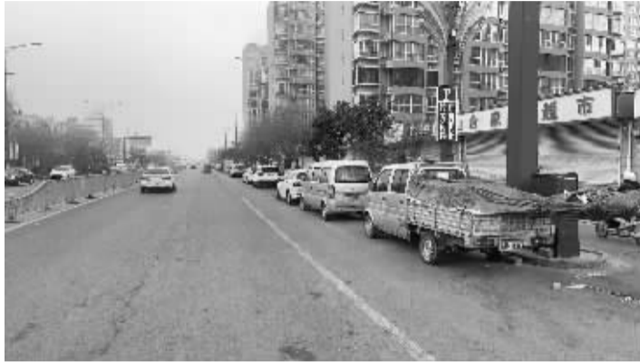
■改造前,路侧停车位占据车道。(警方供图)
