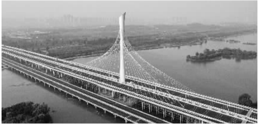
■复兴大街滹沱河大桥。
