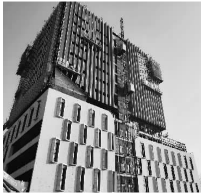
■石家庄市工人文化宫项目施工现场。(住建集团供图)
