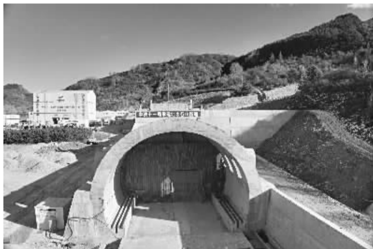
■在山西省忻州市五台山风景名胜区拍摄的雄忻高铁北太行山隧道出口。 新华社记者 杨晨光 摄
