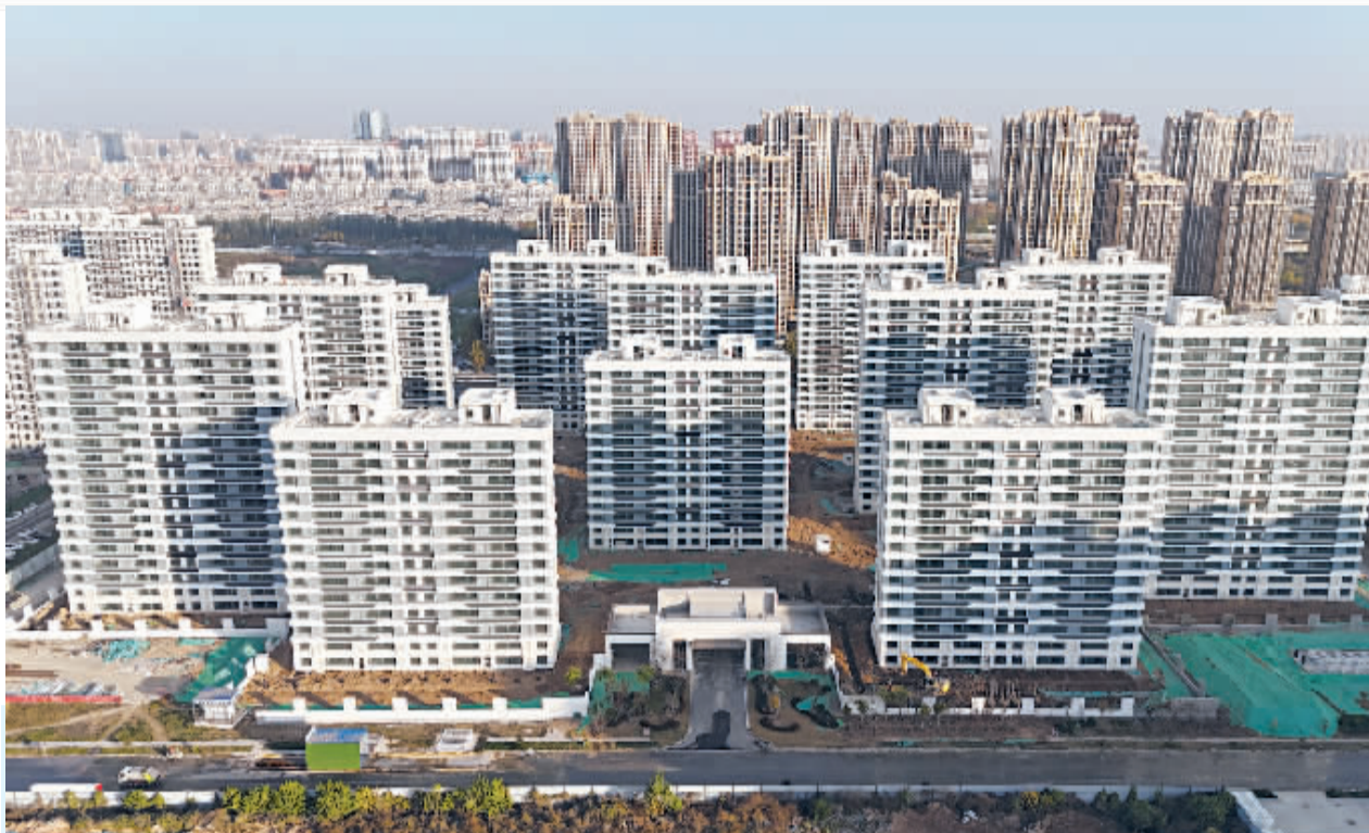
■宋村城中村改造项目回迁区外立面工程全面完成。(住建集团供图)
