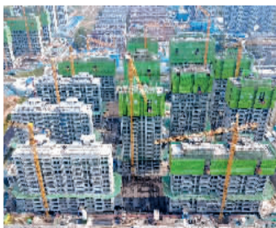
■张营城中村改造项目建设现场(资料图片)。 通讯员 张耀宇 摄
