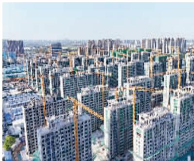
■白佛城中村改造项目建设现场(资料图片)。 通讯员 张耀宇 摄
