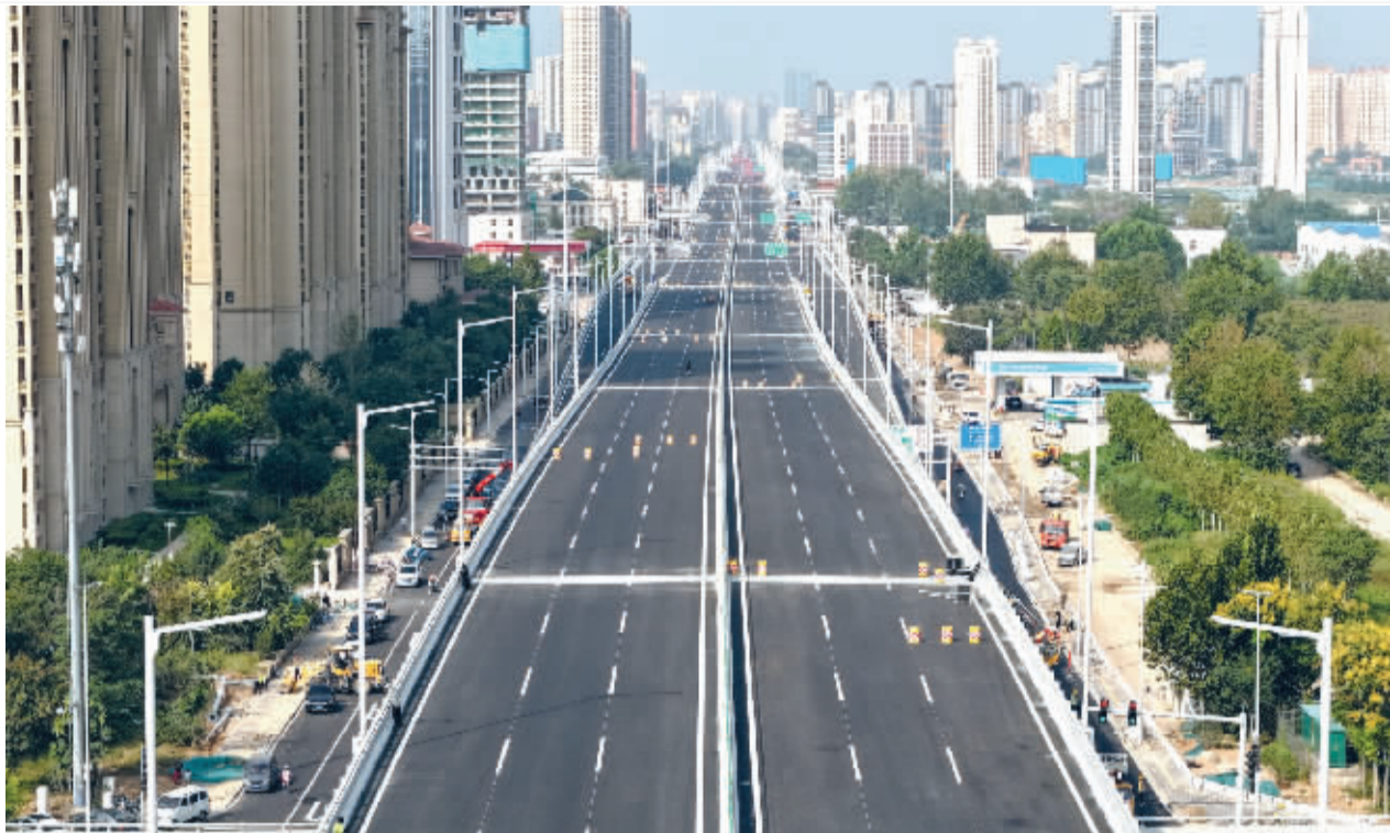
■和平路改造提升工程即将试通车的场景。
