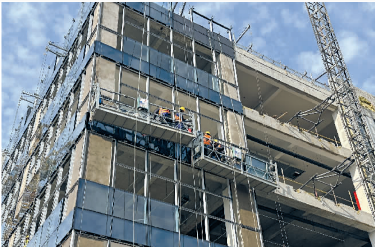
■恒融世通反无人机装备产业链项目施工现场。(资料图片)
