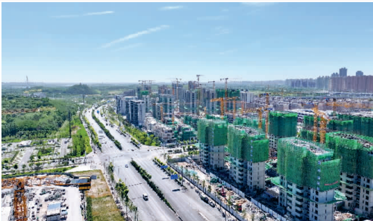
■太平河片区建设现场热火朝天。
