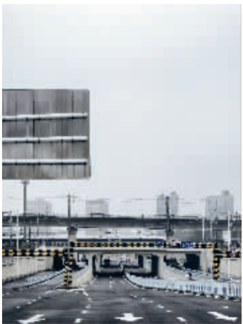
■上方,高铁呼啸而过;下方,仓丰路正进行最后工程收尾。(资料图片) 本报记者 冯月静 摄
