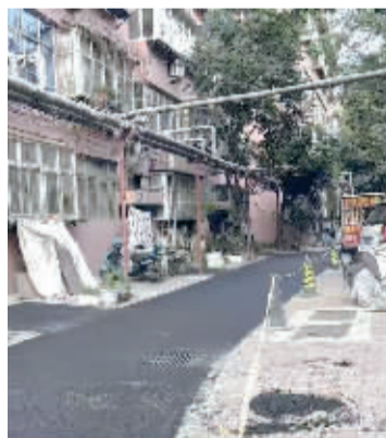
■石泵宿舍路面改造。
