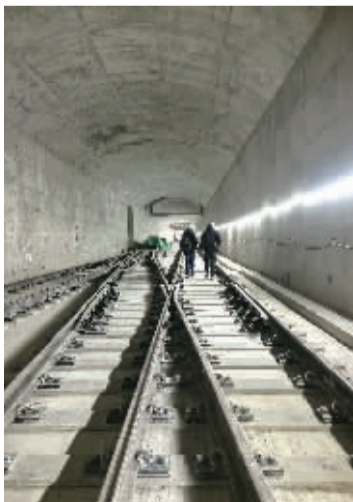
■在地铁4号线,体育公园站铺轨基地内,铺设好的轨道向前延伸。 本报记者 冯月静 摄
