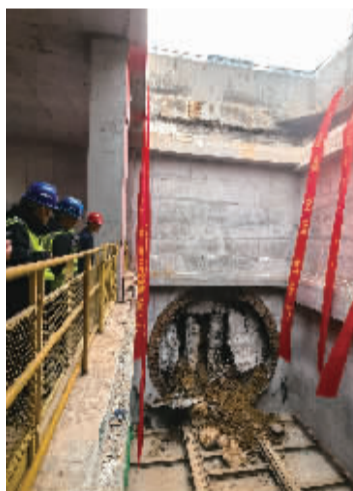
■盾构机正轰鸣作业,刀盘已隐约可见,建设者们都目不转睛地盯着洞口。 本报记者 冯月静 摄
