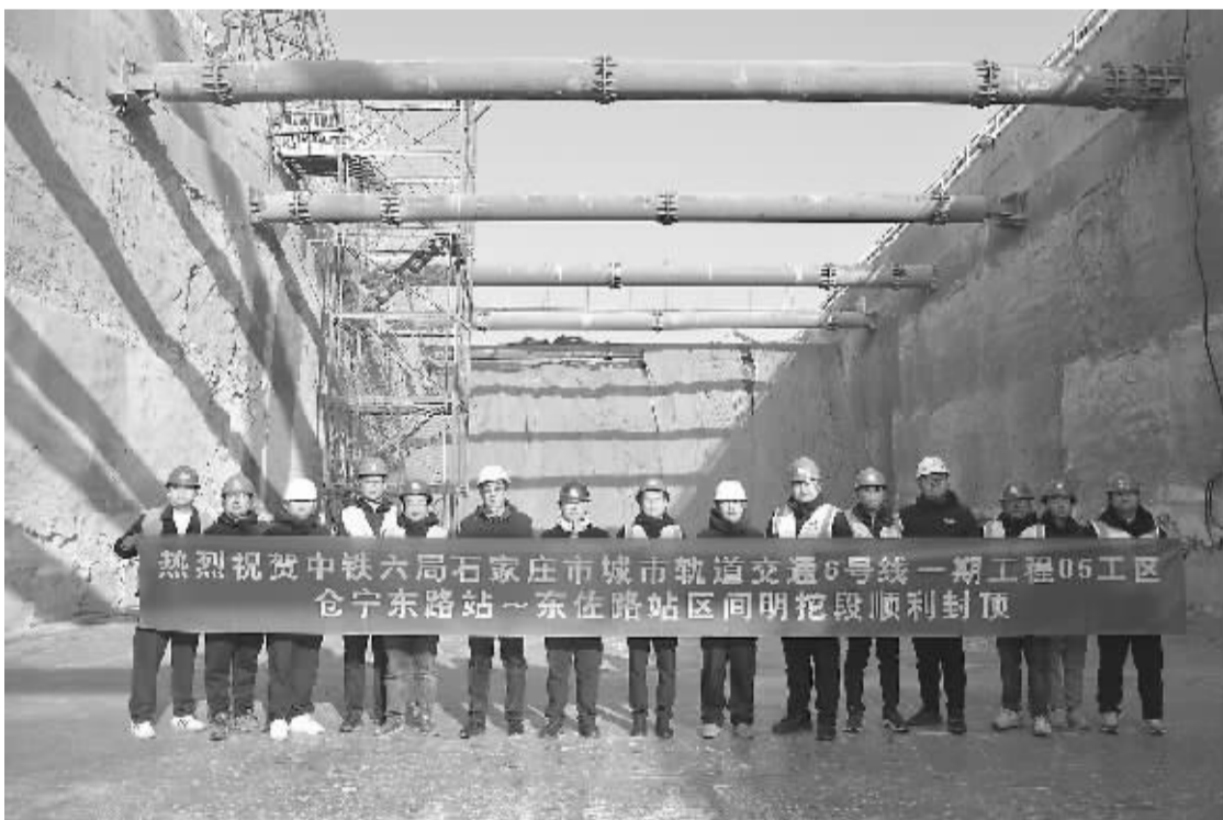
■地铁6号线一期工程仓宁东路站-东佐路站区间明挖段封顶。通讯员 田张梦 摄
