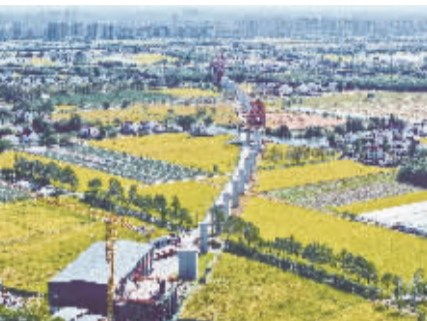
■正在建设中的沪苏嘉城际铁路。
