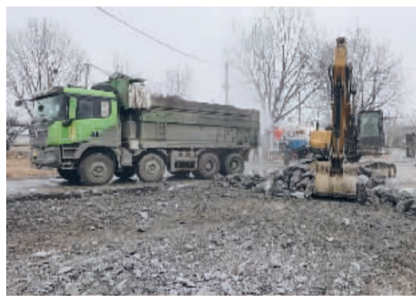
■石家庄市行唐县团贾公路高七里峰段施工时场景。 通讯员 王涛 摄(资料图片)
