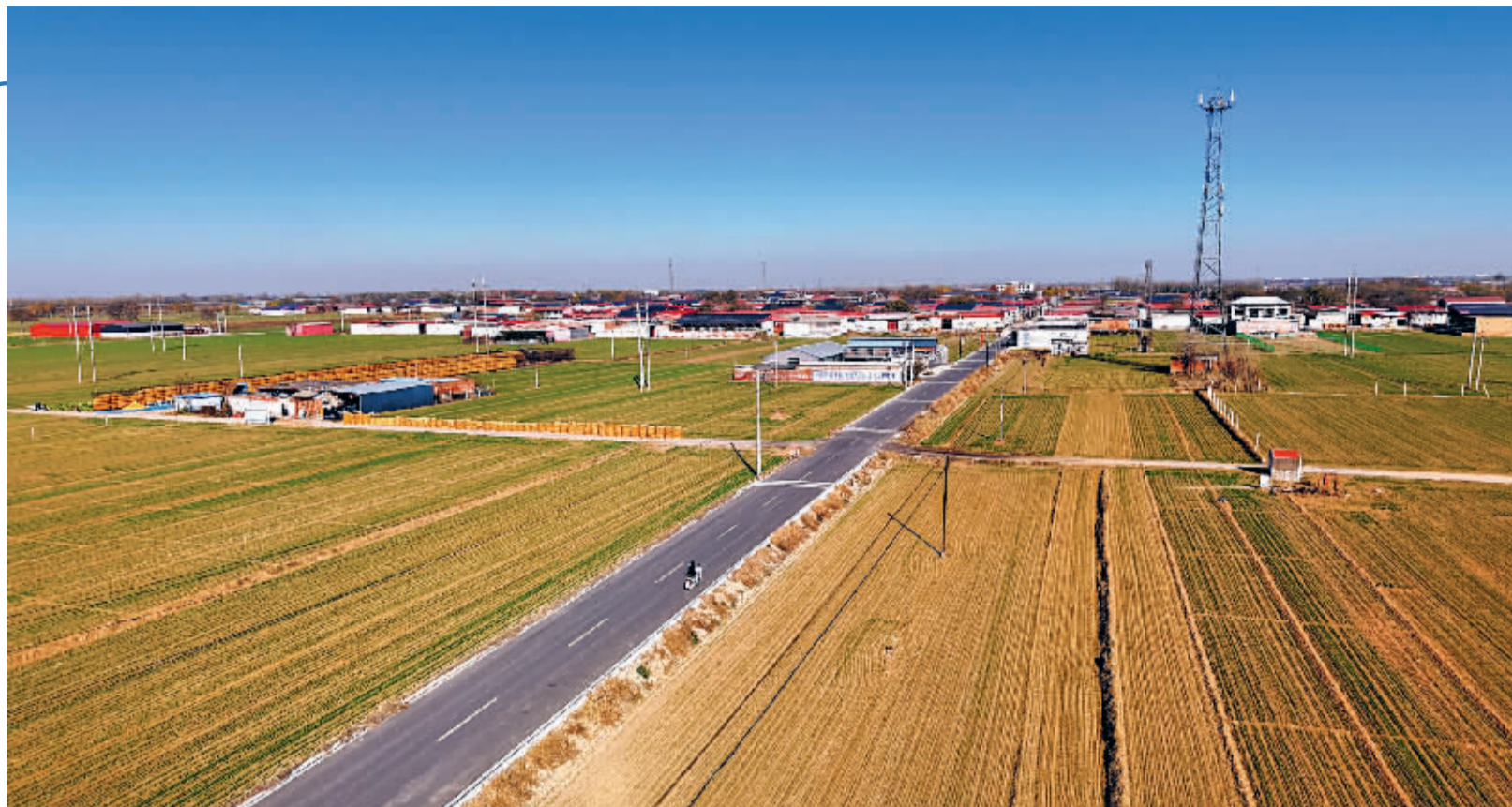
■石家庄市赵县赵赞线-马平路工程,与周边的田园、村落组成为一道靓丽的风景线。(市交通运输局供图)
