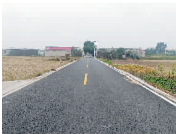
■石家庄市高邑县乡道白西线(国道339-城照段)。
