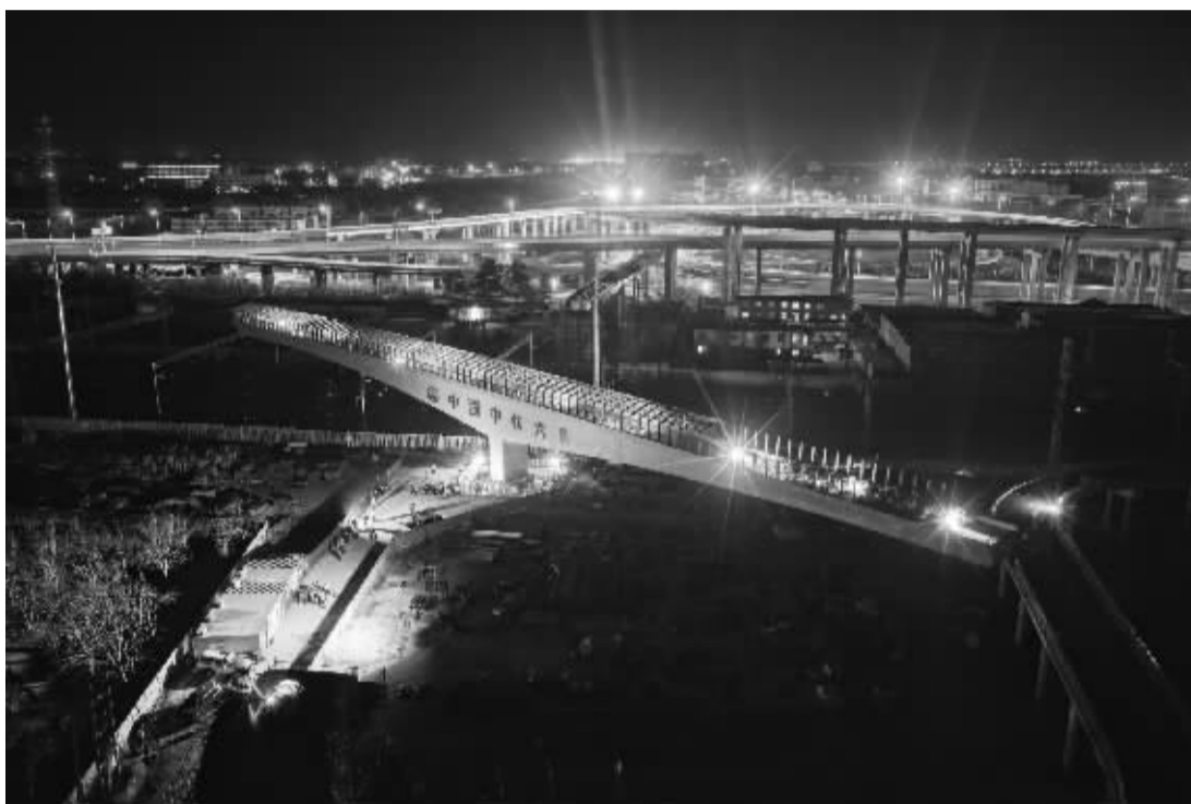
■转体桥正在转体中。
