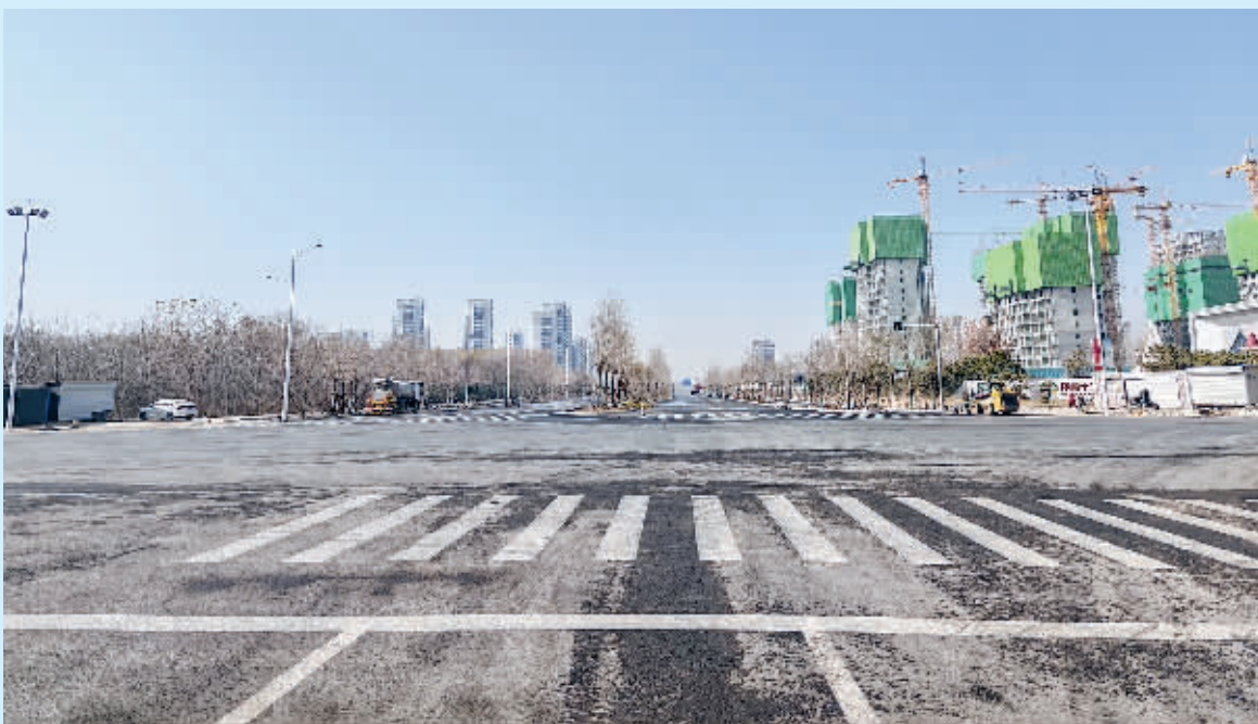
■洺河大道(天山大街—珠峰大街)道路工程已通车。
