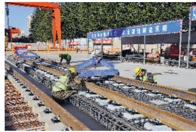
■石家庄地铁4号线体育公园站铺轨基地,建设者进行铺轨作业。 本报记者 崔虹 摄
