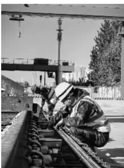
■建设者正拧紧轨排的螺母。
