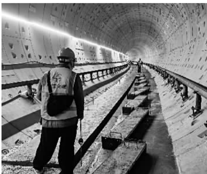
■测绘人员正在隧道内进行测绘。
