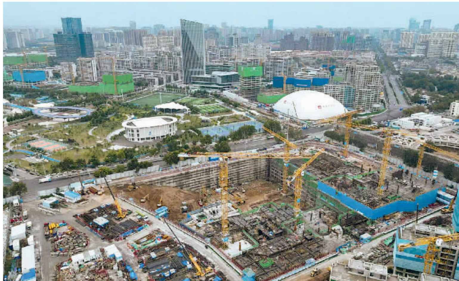
■正在建设中的高铁片区。
