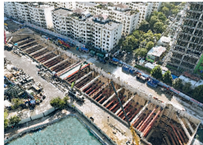
■石家庄地铁5号线一期工程正在建设中。
