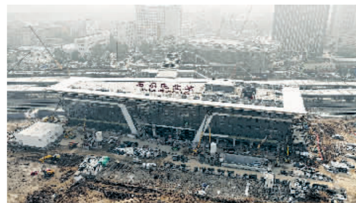
■石家庄北站北广场正在施工中。本报首席记者 张海强 摄
