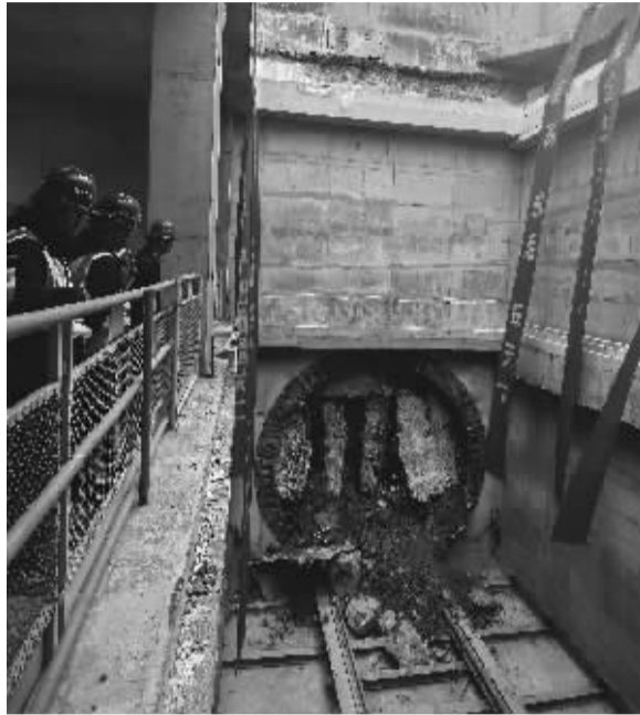
■盾构机正轰鸣作业,刀盘已隐约可见,建设者们都目不转睛地盯着洞口。
