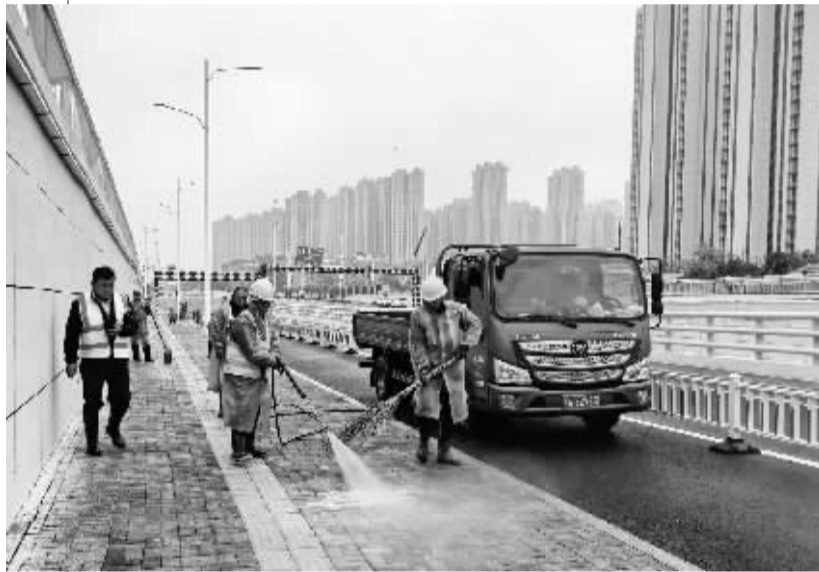
■在雨中,建设者们正在进行最后的清扫和收尾工作。
