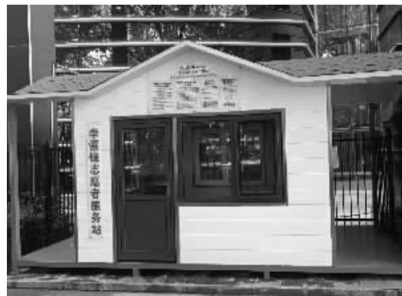
■改造提升后的世纪公园便民服务站。
