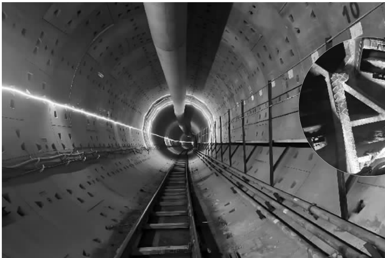
■上庄站 - 西王站区间左线已完成掘进的盾构隧道向前延伸。(轨道集团供图)
