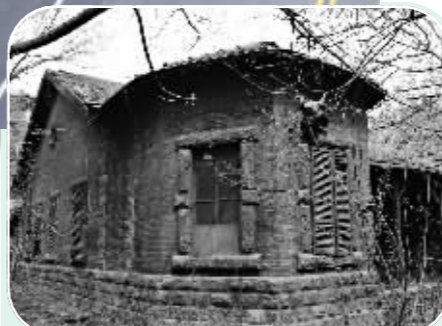
■法式别墅修缮前风貌。(城投集团供图)
