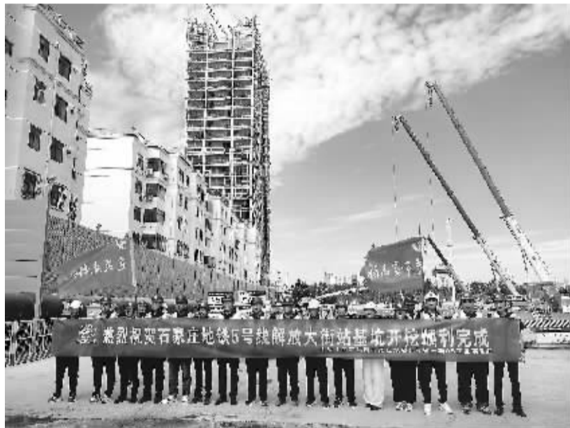
建设者们庆祝基坑开挖完成。
