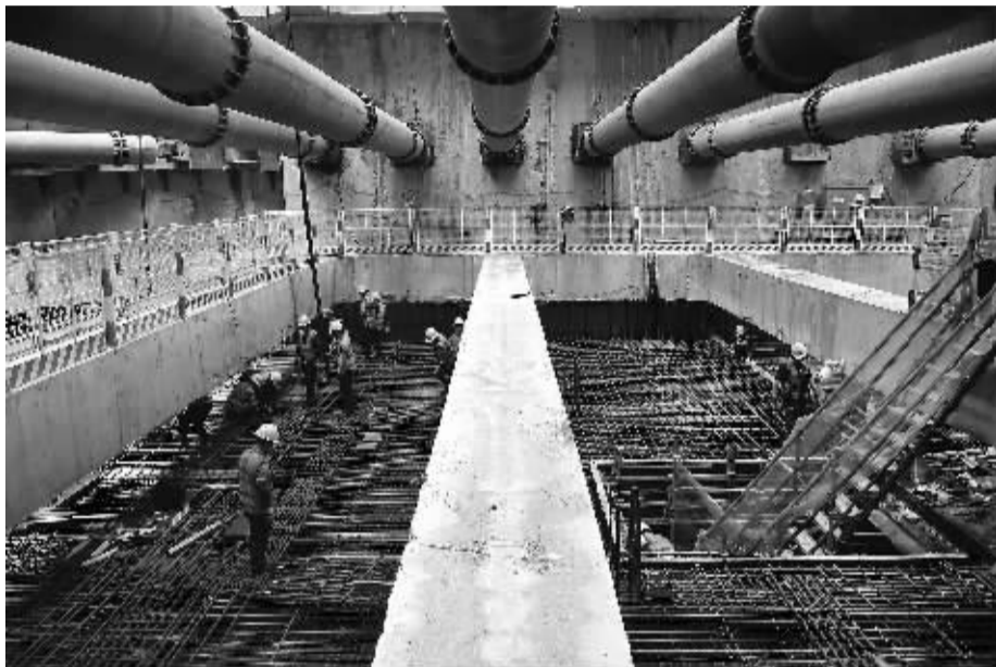
建设者们正在忙碌着进行钢筋绑扎。
