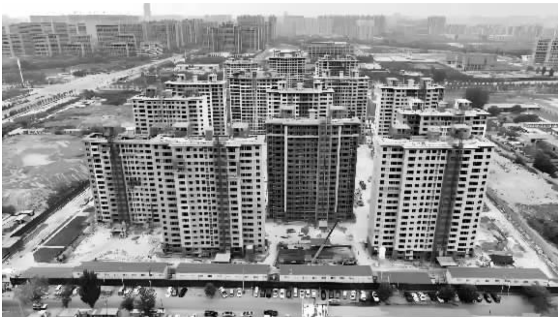
■东南三环片区回迁首开区建设现场。(石家庄交投集团所属市交通地产集团供图)
