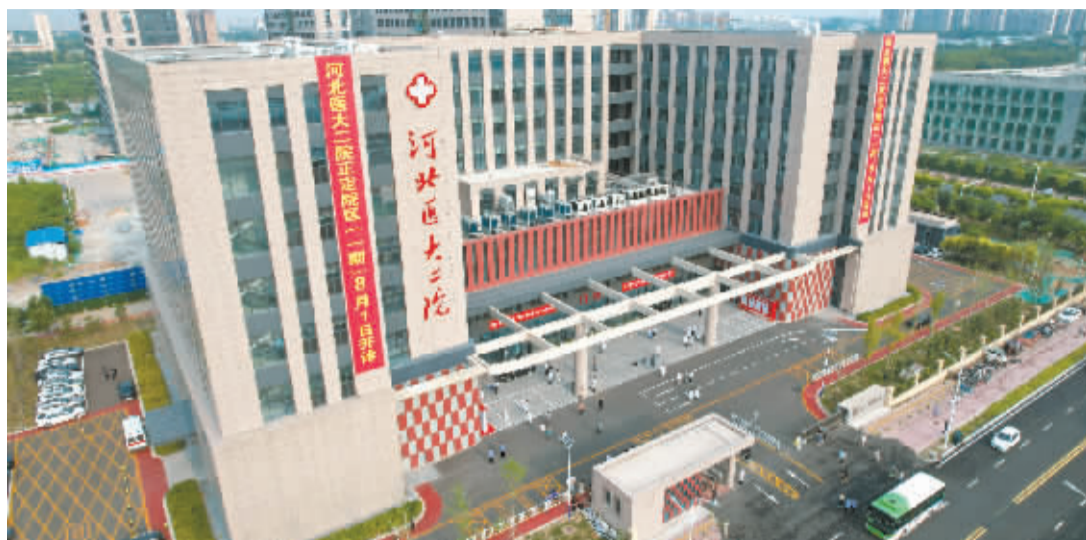
■河北医大二院正定院区(一期)建筑面积2.6万平方米,主体建筑地上7层(局部3层),地下1层。
