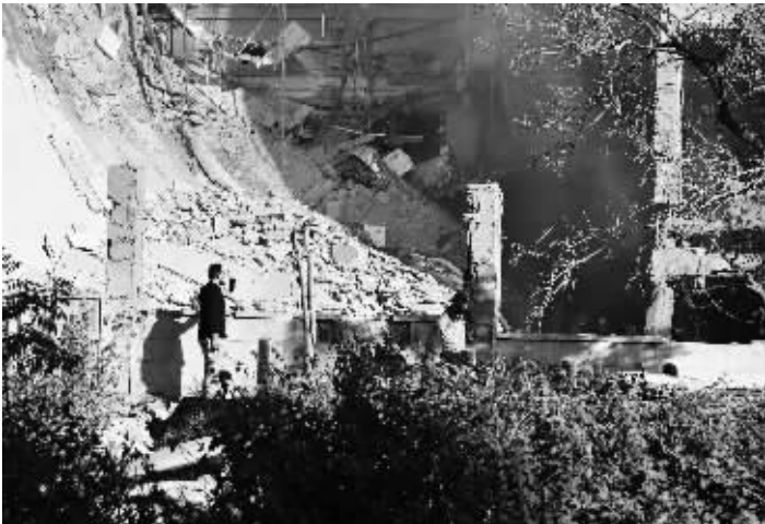
■以色列空袭中受损的叙“总参谋部”大楼。 新华社发
