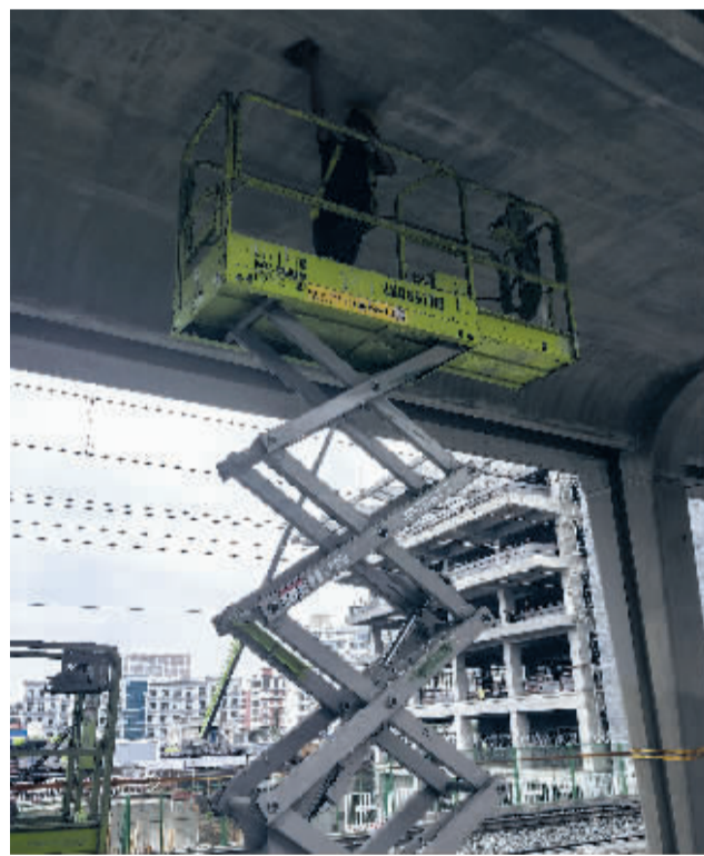
建设者正在用砂纸打磨顶棚。
