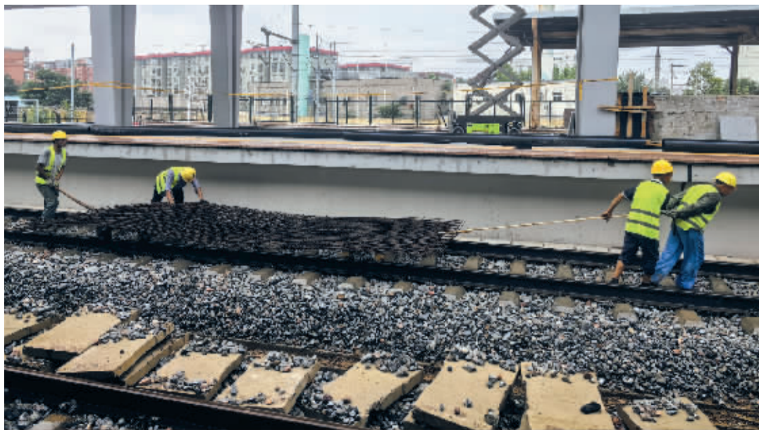
几名建设者正在费力地运送1000多斤的钢筋网片。
