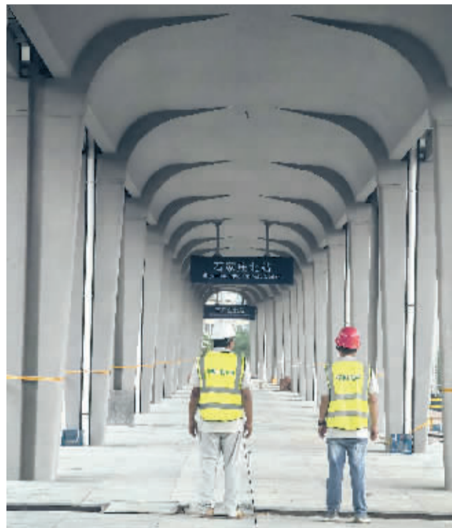
主体已完工的雨棚,增加了弧度,显得更加美观。
