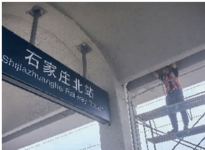
建设者正站在脚手架上,安装桥架。
