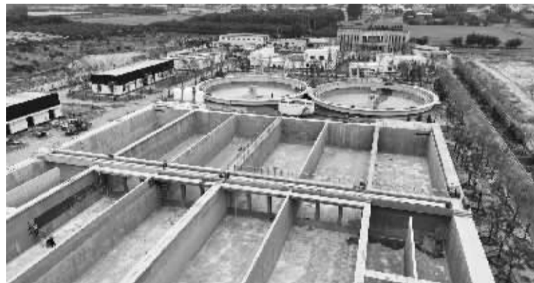
■长安区污水处理厂项目主体工程全部完工。
