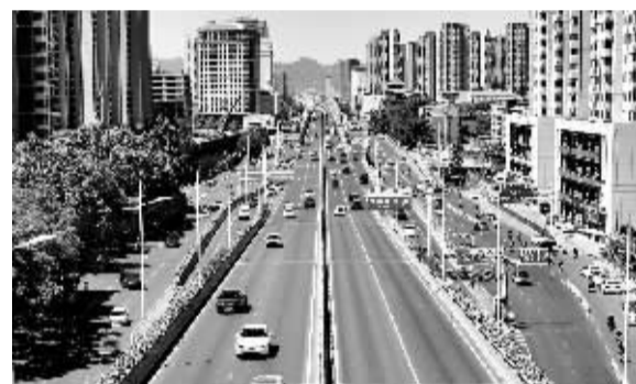
■高架桥上挂满鲜花，形成“空中花廊”。
