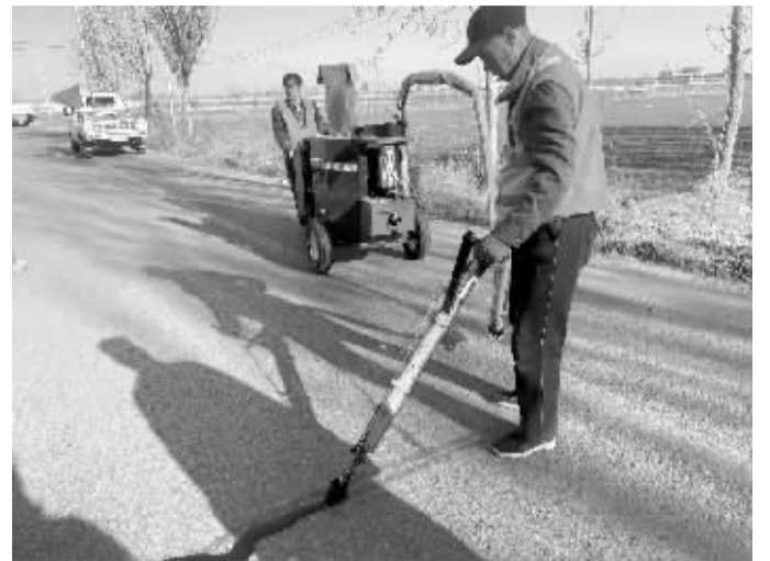
■工人正在进行小修灌缝作业。通讯员 邱雪 摄
