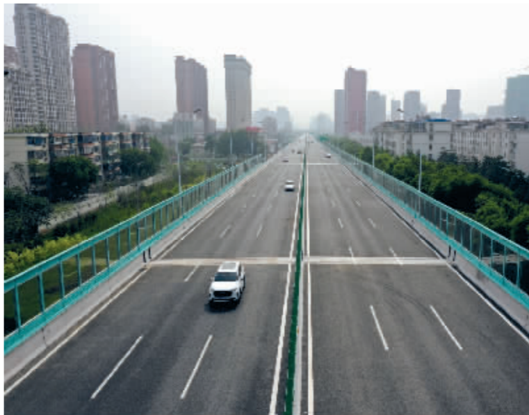
■槐安路高架桥西延。
