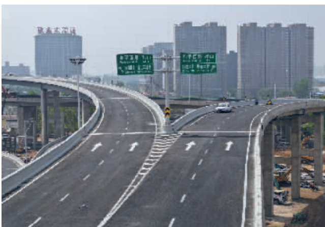
■和平路与西三环互通立交工程匝道。
