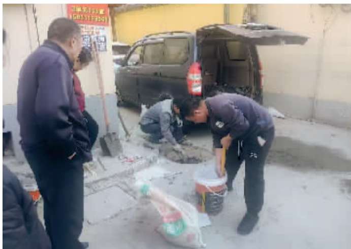
■针对地下室渗水问题,施工人员正在施工。(社区供图)
