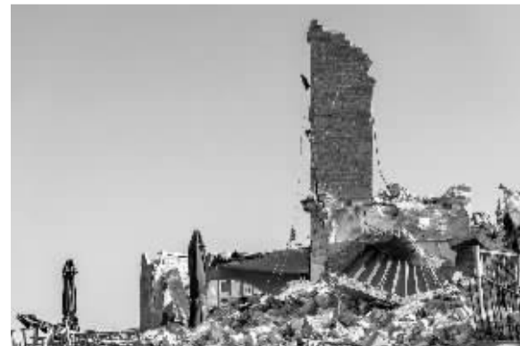
■这是 3 月 16 日在荷兰法尔肯堡拍摄的石塔坍塌现场。
