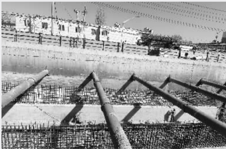
■体育北大街站正在进行中板施工。
