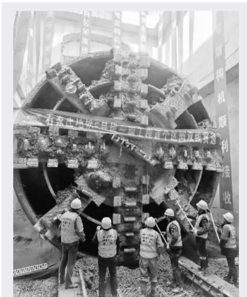
■建设者正在清理刀盘上的泥土。
