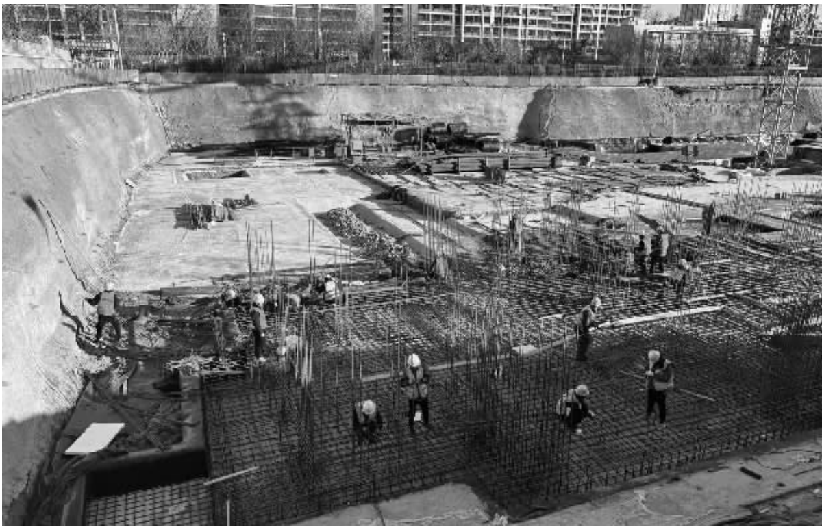
■华药南厂区地块项目建设现场热火朝天。本报记者 冯月静 摄
