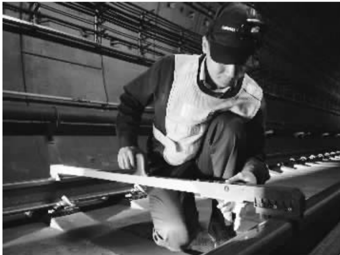
■轨道技工刘丰银用道尺测量钢轨轨距。(市轨道集团供图)
