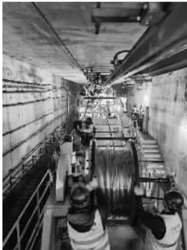
■首次接触网换线作业顺利完成。
