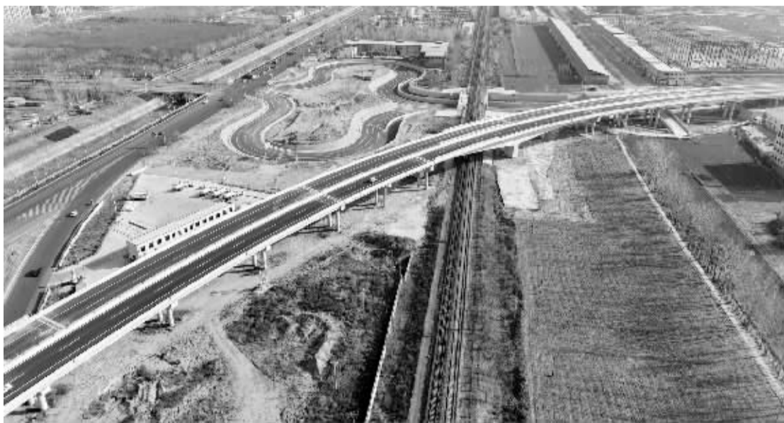
晋州市外环线全线贯通。(石市交通运输局供图)
