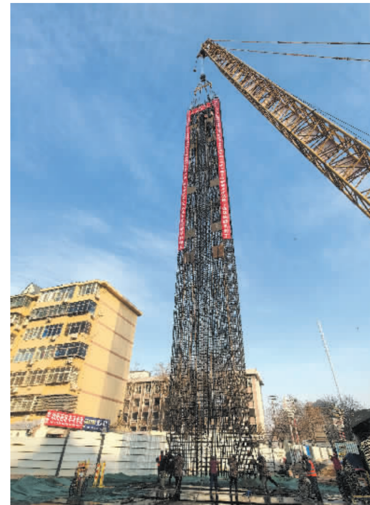
■2024 年 12 月 24 日,石家庄地铁 5 号线解放大街站最后一幅地连墙钢筋笼入地浇筑。本报记者 冯月静 摄
