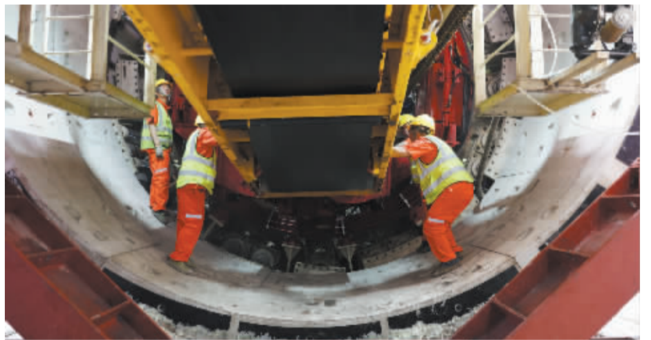
■地铁4号线省广电总台站盾构机顺利分体始发。
