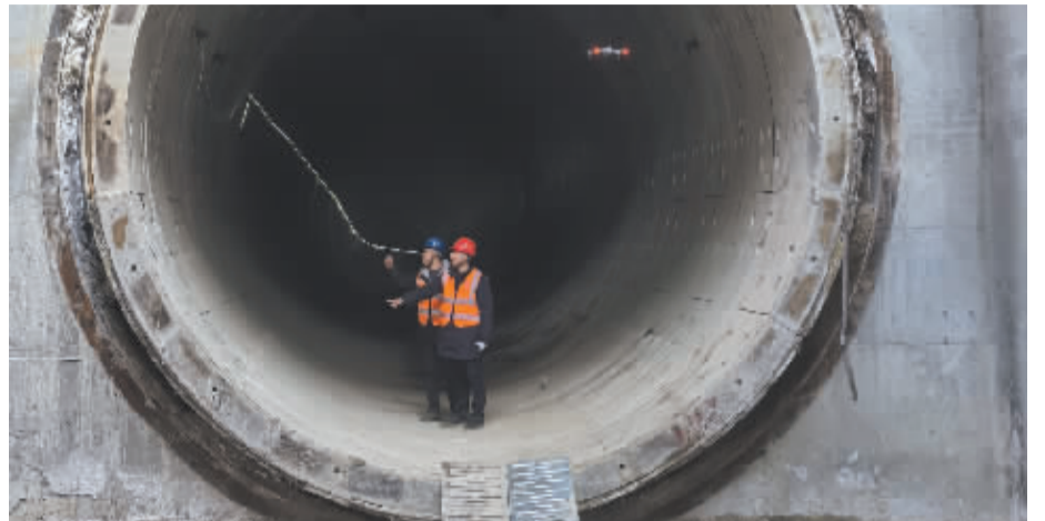
■地铁4号线最长区间双线贯通。
